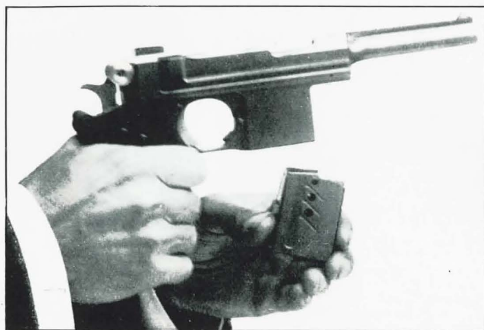
FIG. 7 UND 8. — Herausnehmen des Magazins
